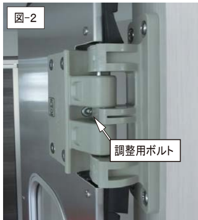
ドアを70° 開くと調整用ボルトが見えます
