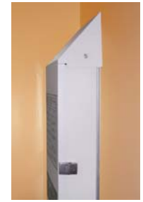
▲施工例 / 制御盤用傾斜カバー
