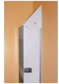
▲施工例 / 制御盤用傾斜カバー
