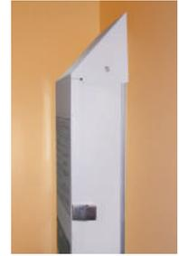
▲施工例 / 制御盤用傾斜カバー
