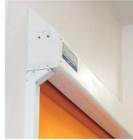
▲施工例 / 本体ボックス用傾斜カバー
